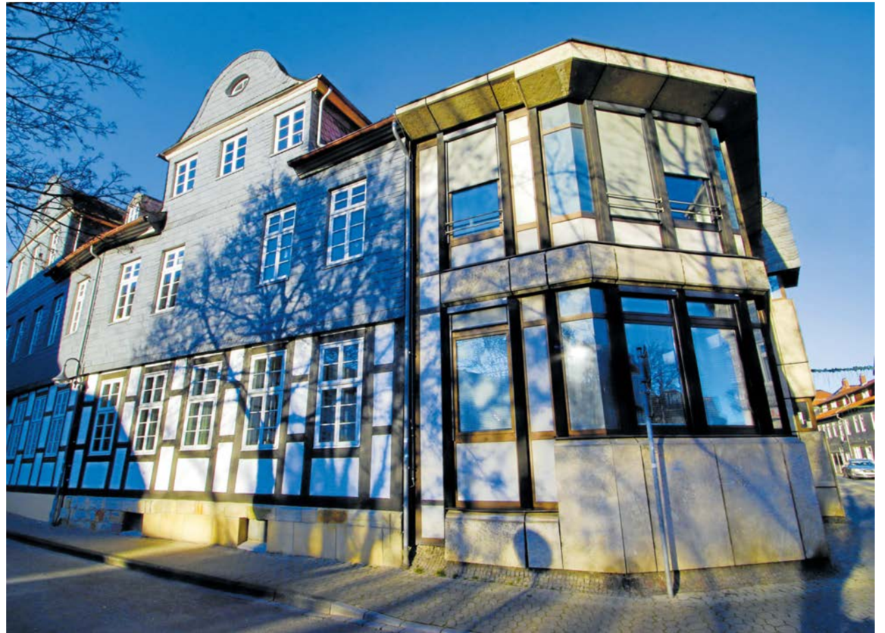
Gilt für nach dem Lockdown: Das Hauptgebäude der Stadtverwaltung an der Charley-Jacob-Straße wird nach wie vor als wesentliches Element zur Belebung der Innenstadt gesehen. Foto: Epping
